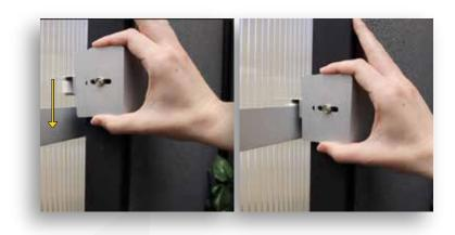
7. REPEAT STEPS 2-3 FOR TOP BRACKET. PLACE TOP BRACKET AROUND CUBICLE EDGE AND SLIDE DOWN OVER DOOR GUIDE RAIL.
